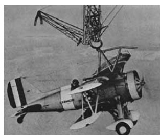
〔機体の収容フック部〕
